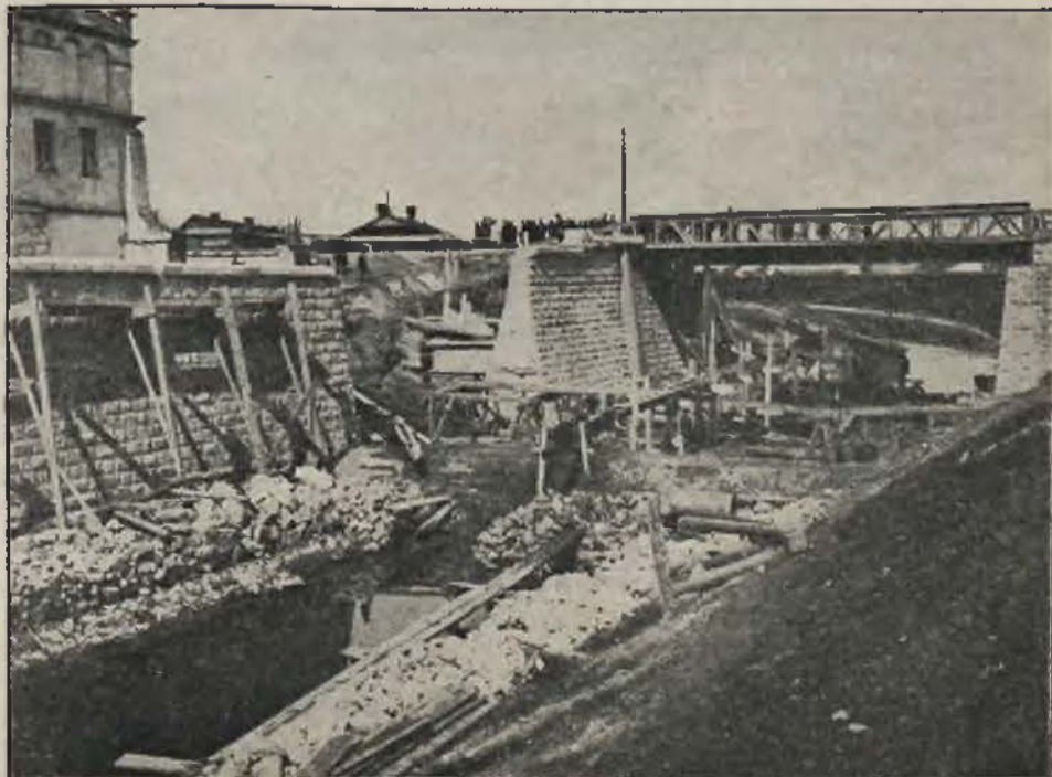
Nowe koryto Rudawy z nowym mostem.
